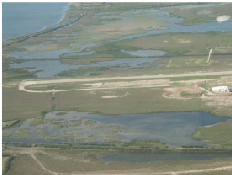
Vue aérienne du site de l'aérodrome avec le taxiway en partie réalisé (Photo CBE Mai 2003)
